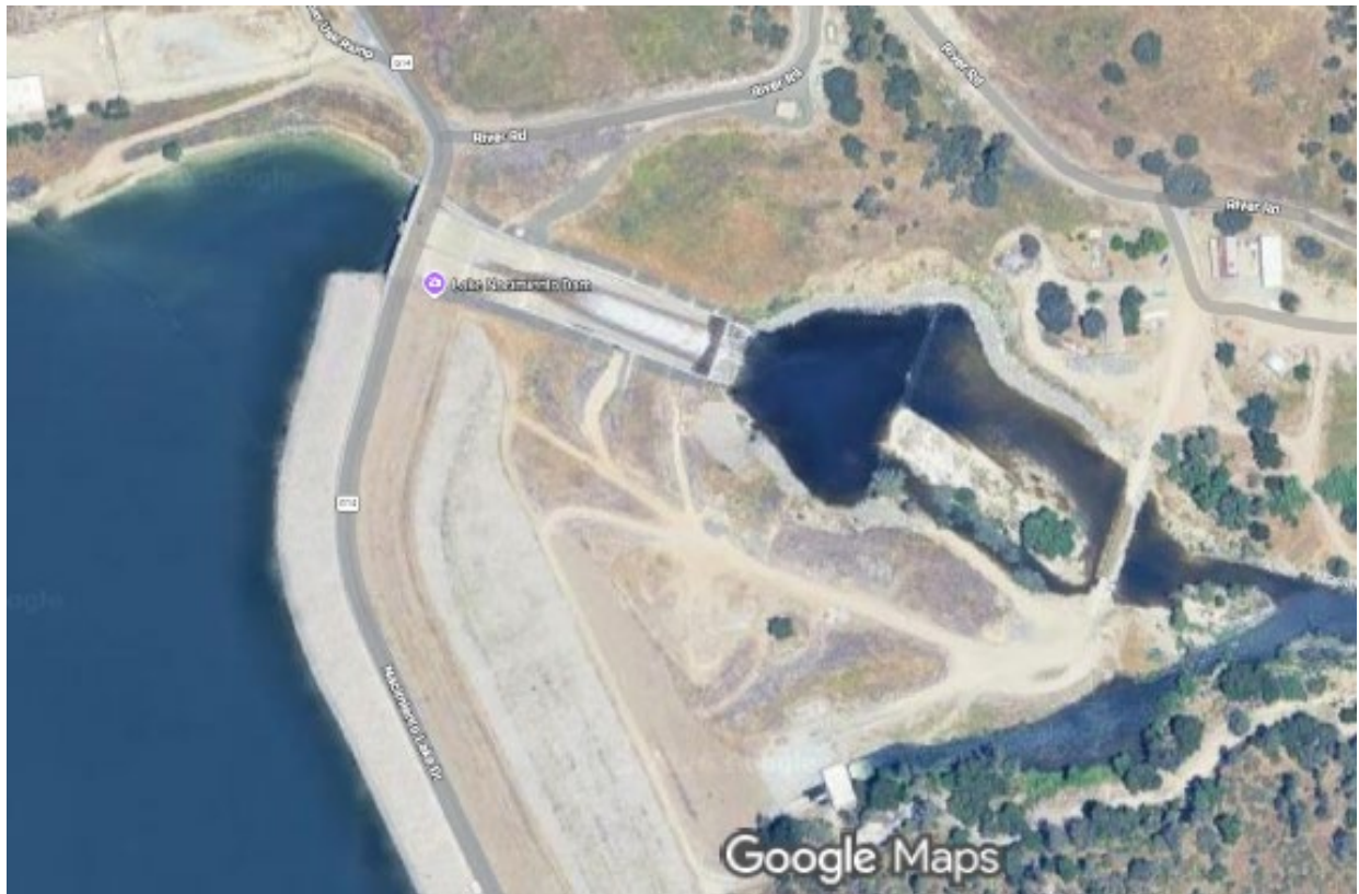
Figure 3: Nacimiento Dam Spillway Plunge Pool
